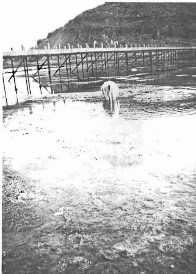
5.- ESTACION : PUENTE YOROCO RIO COATA
