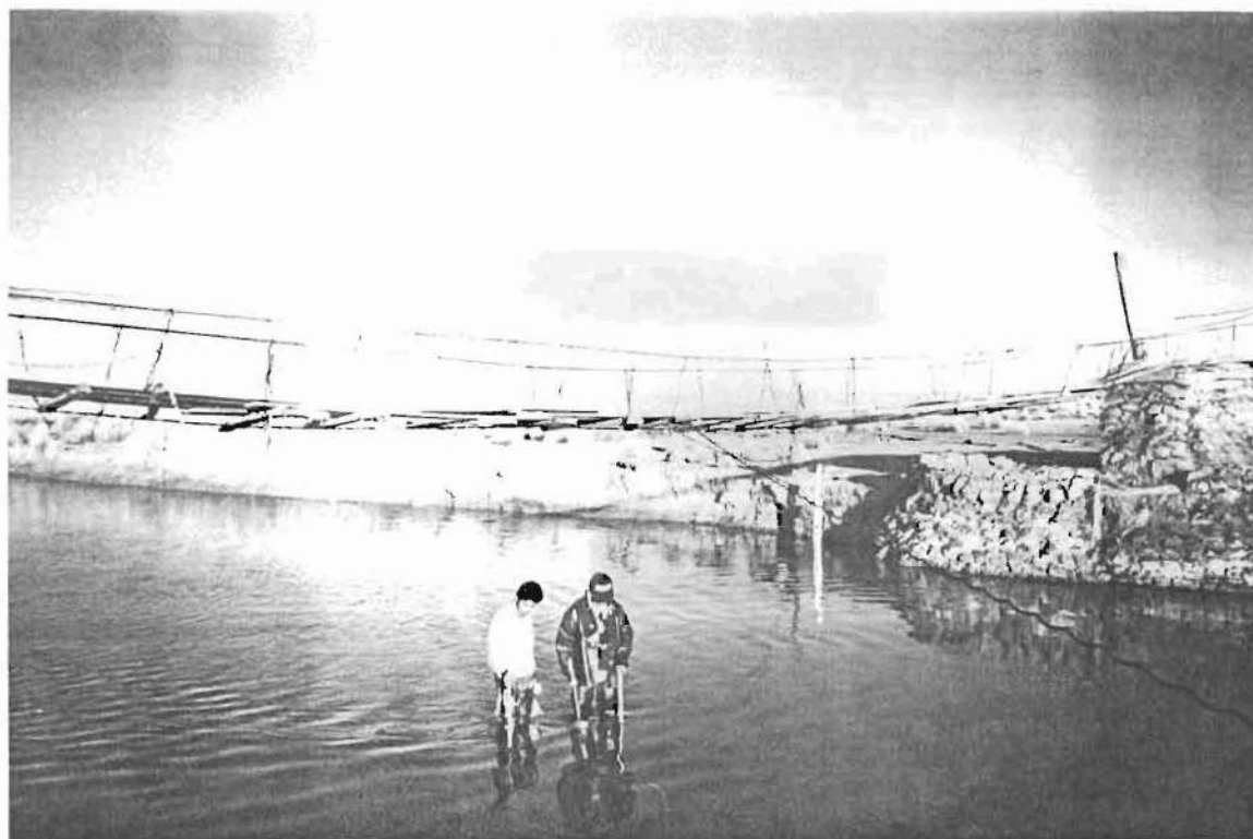
35.- ESTACION: PUENTE BURGUILLOS
